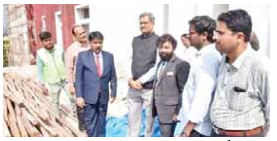
నిర్మాణ పనులు కొనసాగుతున్న చిత్తూరు జిల్లా కోర్టును పరిశీలిస్తున్న జస్టిస్ రావు రాఘనందన రావు
