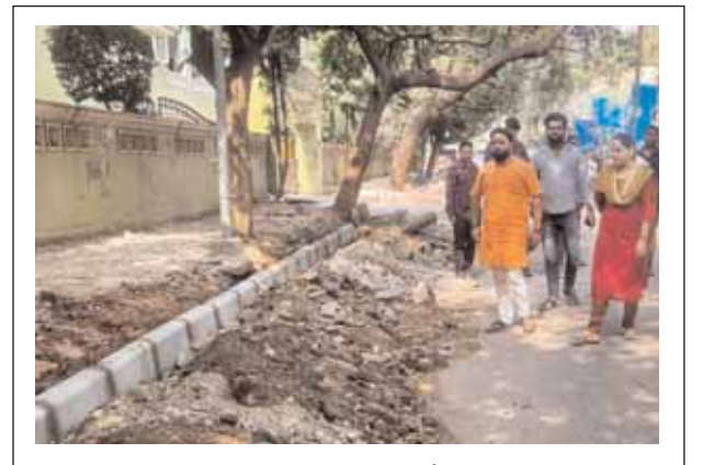
ఫుల్పాతల్ నిర్మాణం: రూ.41లక్షల బడ్జెట్ తో జరుగుతున్న ఫుల్పాతల్ క్రమబద్ధీకరణ పనులు, కొత్త ఫుల్పాతల్ నిర్మాణపనులను గాంధీనగర్ కార్పొరేటర్ ఏ.పాపసీవినయకుమార్ పర్యవేక్షించారు. -ముషీరాబాద్, మేజర్ న్యూస్
