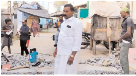
అభివృద్ధి పనులను పరిశీలిస్తున్న మునయ్య
