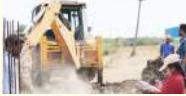
పై నిర్మించిన ర్యాంప్ ను, సాయి బాబా టెంపుల్ వెనక ఆది రాస్తా లో నిర్మిస్తున్న నిర్మాణం లను తొలగించడం జరిగినది. అలాగే
