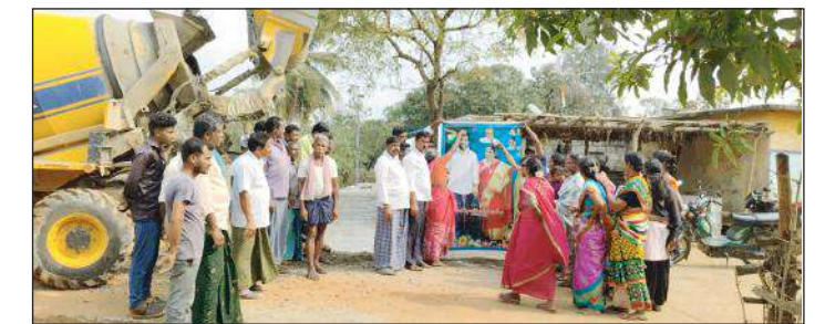
రామచంద్రపురంలో సిసి రోడ్ల నిర్మాణ పనులు
