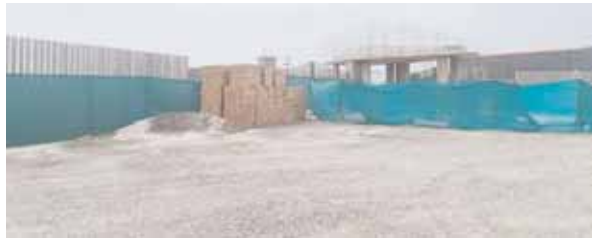
నిర్మాణ దశలో ఫామ్ ల్యాండ్ ప్రధాన గేటు
