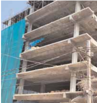
క్యూ సిటీలో నిర్మాణ దశలో బహుళ అంతస్తుల నిర్మాణం
