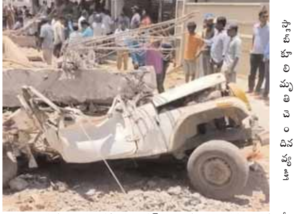
వంగిలి మెతుకులు అలా పడి మున్సిపల్ అధికారులూ వ్యవహరించడంతో పై స్లాబ్ నాసిరకంగా నిర్మాణం కావడంతో ఈ ఘటన జరిగిపోయిందని పలువురు అంటున్నారు. మున్సిపల్ అధికారులపై, భవన నిర్మాణ యజమాని పై చర్యలు తీసుకోవాలని పలువురు డిమాండ్ చేస్తున్నారు.
