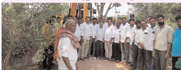
బీటీ రోడ్డు పనులను ప్రారంభిస్తున్న కాంగ్రెస్ నాయకులు
