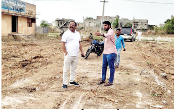
పనులను పరిశీలిస్తున్న కమీషనర్
