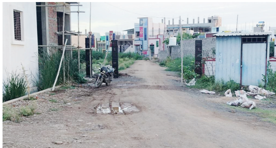
మరో రహదారిపై పూర్తైన పిల్లర్ల నిర్మాణం
