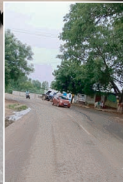
జగన్నాథపురం బస్టాండ్ వద్ద ప్రమాదకర మూలములు
