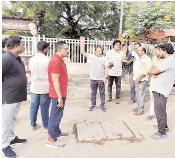
పనులను పరిశీలిస్తున్న కమీషనర్
