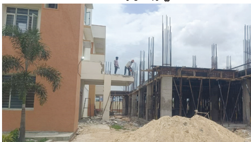
ఆసుపత్రిలో నిర్మిస్తున్న ఇన్సెంటివ్ కేర్ భవన పనులు.
