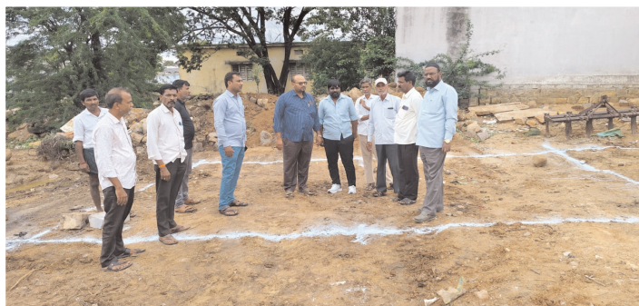
పెద్దేముల్ మండల మంజూరైతలో ఇందిరమ్మ ఇండ్ల పనులను పరిశీలిస్తున్న డీఈఈ కలీం
