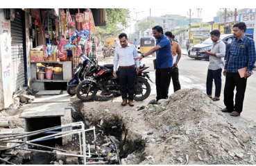
పనులను పరిశీలిస్తున్న కమీషనర్
