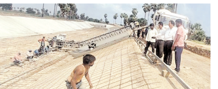
నాణ్యతగా నిర్మించాలంటున్న బోర్డు ఎన్ఈ
