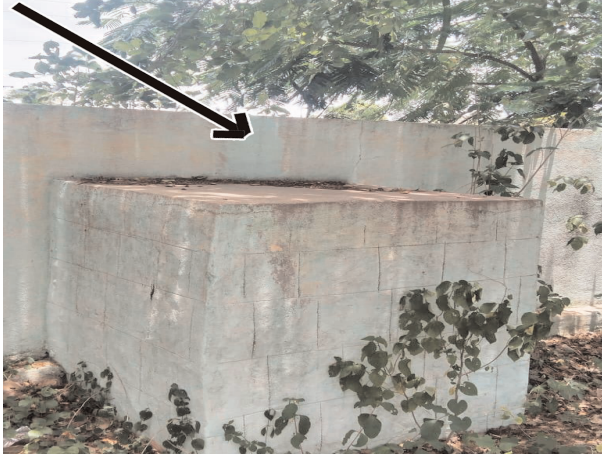
పిహెచ్‌సి ఆవరణలో మంజూరైన ట్రాన్స్‌ఫార్మర్ ఏర్పాటుకు నిర్మించిన దిమ్మె
