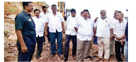
రహదారి పనులను పరిశీలిస్తున్న ఎమ్మెల్యే జయసూర్య
