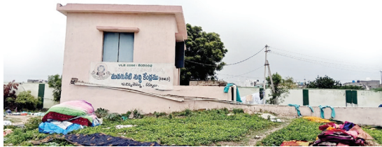
పనిచేయని 0.8ఎంఎల్డి ఎస్టిపి కేంద్రం
