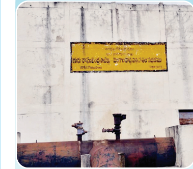
నిరుపయోగంగా ఉన్న ముగులదొడ్డి పంప్ హౌస్
