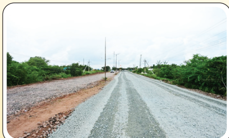
ప్రధాని సభా వేదిక వద్ద అంతర్గత రహదారుల నిర్మాణం
