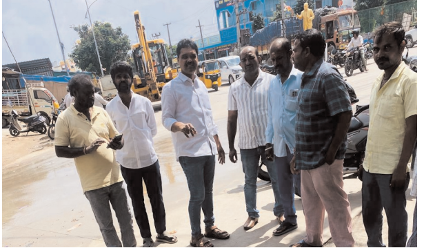
బాలాపూర్, మేజర్ న్యూస్ (అక్టోబర్ 15): అల్మాన్ గూడ గ్రామ పరిధిలోని వైయస్సార్ పార్క్ వద్ద అండర్ గ్రౌండ్ డ్రైనేజీ లీకేజీ కారణంగా మురుగు నీరు రోడ్డుపై పారుతుండటంతో 24, 25వ డివిజన్లకు చెందిన ప్రజలు తీవ్ర ఇబ్బందులు ఎదుర్కొంటున్నారు. గత నెల రోజులుగా కురుస్తున్న అధిక వర్షాల
