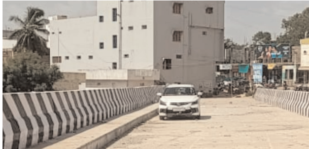
షాద్ నగర్ రోడ్డుపై రోడ్డుకు అడ్డంగా ఉన్న భవనం
