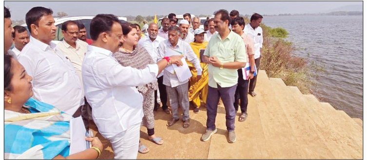
ఎత్తిపోతల పథకం పనులను పరిశీలిస్తున్న ఎమ్మెల్యే బుడ్డా రాజశేఖర్ రెడ్డి, జిల్లా కలెక్టర్ రాజకుమారి గణియా
